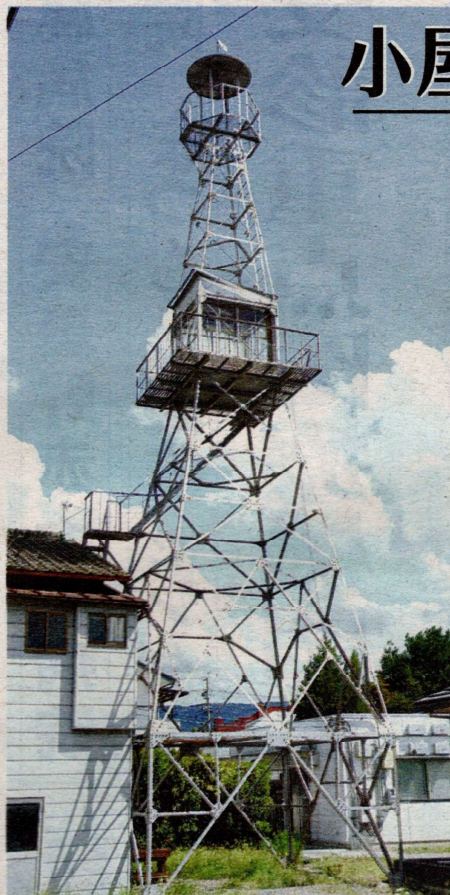
解体が決まった火の見やぐら
