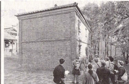
信州大に残る1895年建築の旧長野県庁書籍庫。レンガ造りのため、県庁舎が1908年に焼失した際、焼け残った＝長野市西長野で
